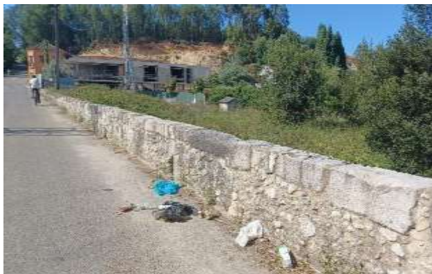
Fig.3 – Poluição na Ponte Pedrinha
